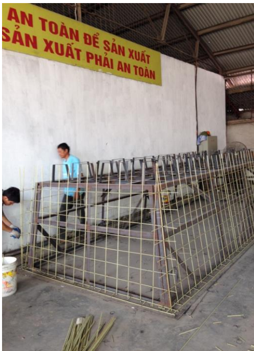
Sử dụng cốt FRP và bê tông thường làm đế chấn sóng dạng thùng chìm
