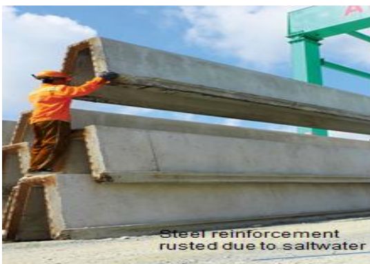
Cọc cừ bê tông cốt thép sử dụng làm tường chắn đất khi cốt thép bị rỉ
