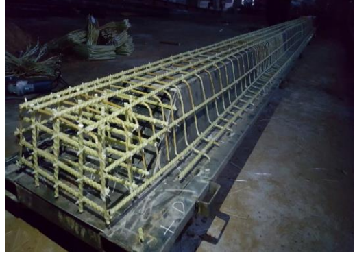
Dùng bê tông chất lượng cao (UHPC) cùng với cốt thép FRP làm ván cừ thay thế ván cừ thép – bố trí thanh FRP trong ván cừ
