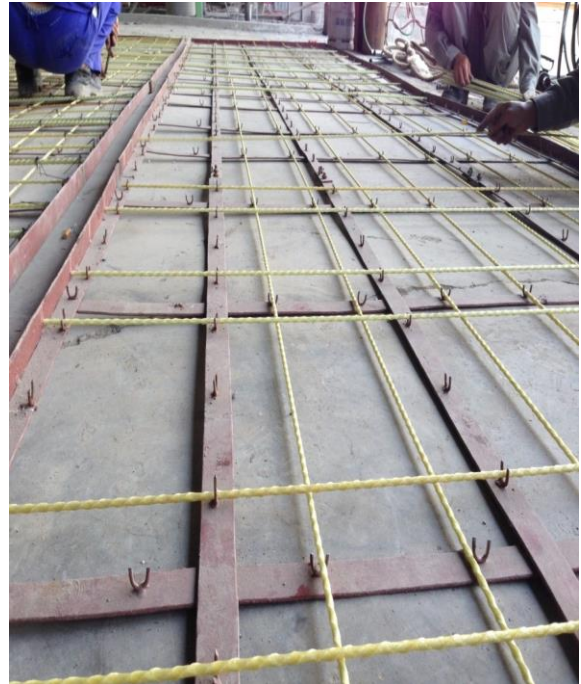
Sử dụng cốt FRP và bê tông thường làm đế chấn sóng dạng thùng chìm
