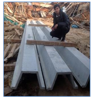
Dùng bê tông chất lượng cao (UHPC) cùng với cốt thép FRP làm ván cừ thay thế ván cừ thép – bố trí thanh FRP trong ván cừ
