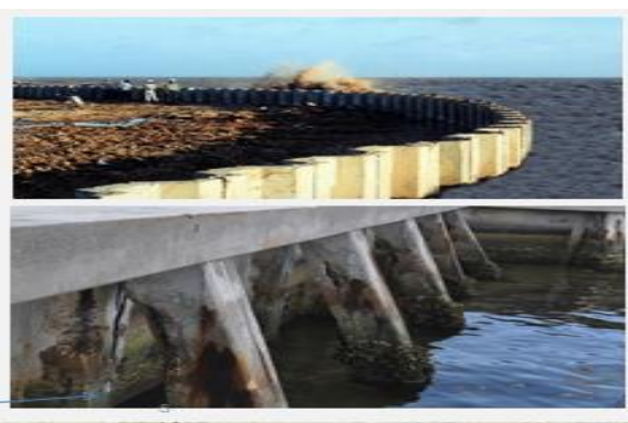
Cọc cừ bê tông cốt thép sử dụng làm tường chắn đất khi cốt thép bị rỉ
