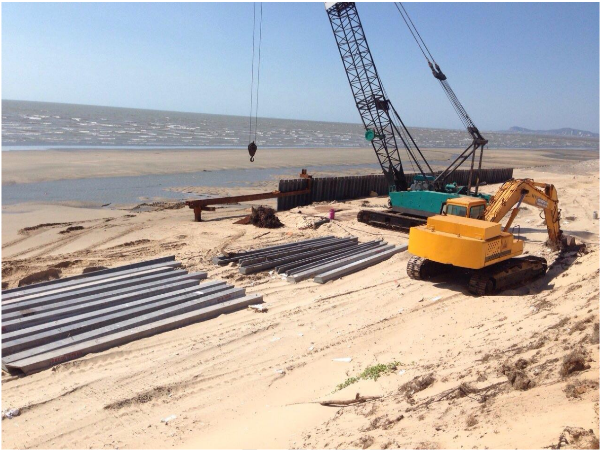
Hàng cọc cừ kè bờ biển (chắn sóng và chống xói lở bờ).
