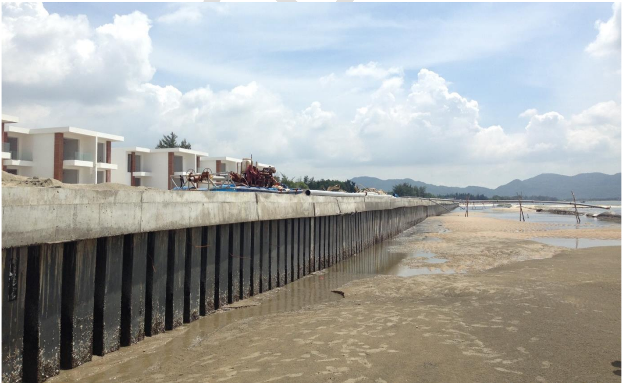
Hàng cọc cừ kè bờ biển chắn sóng và chống xói lở bờ sau khi thi công hoàn thành.
