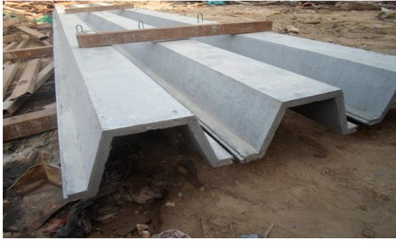
Hình 26: Cọc cừ gia cố nền móng.
