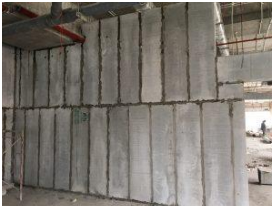
Hình 4-17: Sử dụng tấm tường NUCEALL làm tường ngăn, vách ngăn cho nhà cao tầng.
