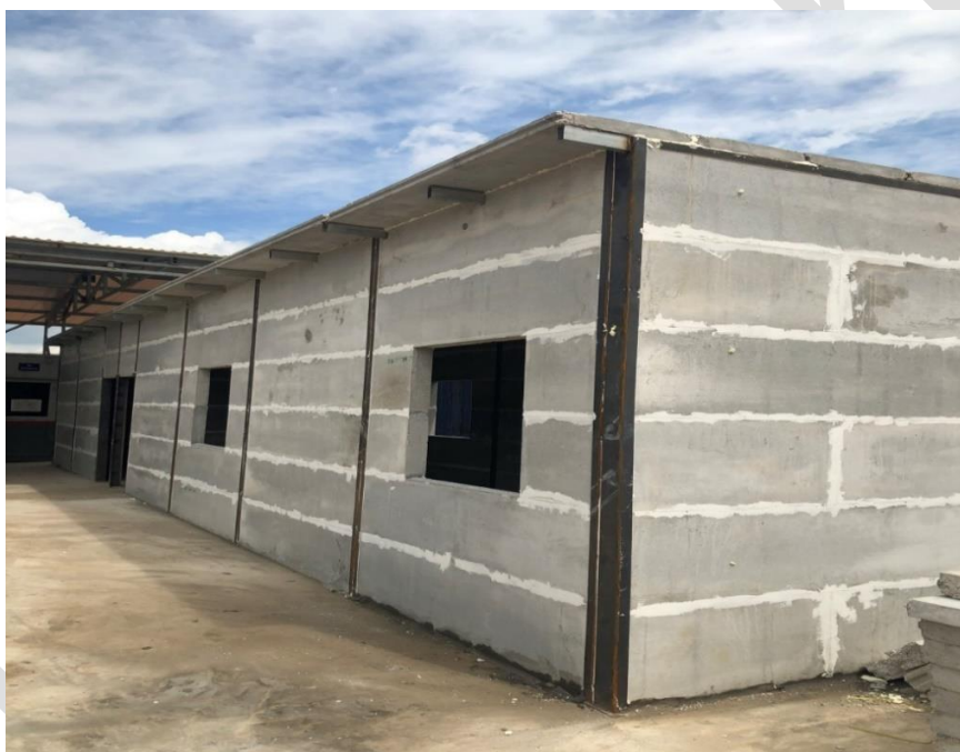
Hình 4-15: Sử dụng tấm tường NUCEWALL xây dựng nhà ở thấp tầng.
