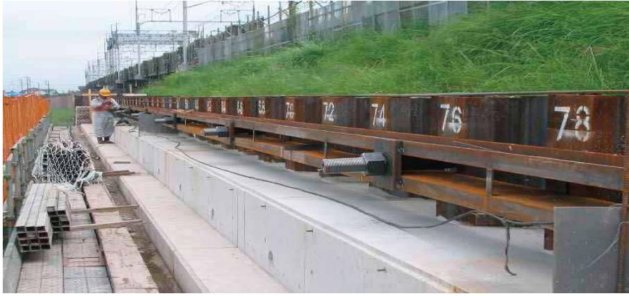
Hình 32: Gia cường chống động đất đối với đường tàu.
