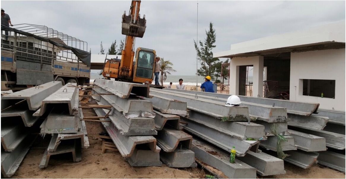
Tập kết cọc cừ NUCEPRO-P tại công trường.
