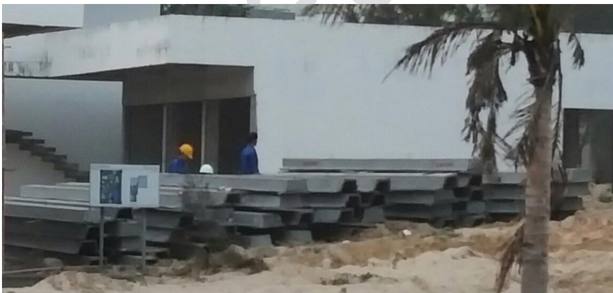
Tập kết cọc cừ NUCEPRO-P tại công trường.
