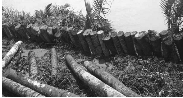
Hình 3: Cọc giữ đất bằng các thân cây dừa
