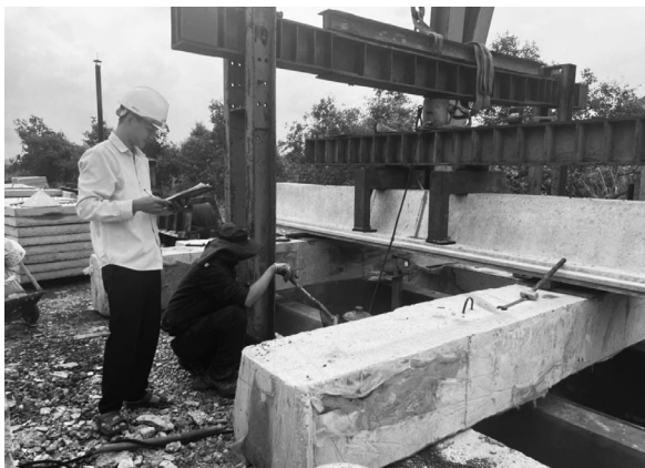
Hình 15: Lắp đặt thí nghiệm thực tế mẫu S3
