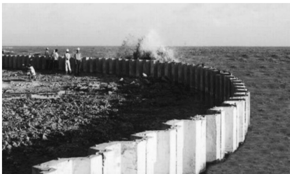
Hình 8: Ván cừ bê tông cốt thép ứng lực trước ven bờ biển
