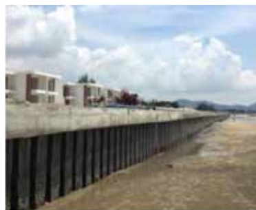
b) - Cừ bê tông cốt GFRP tại Rừng Dương - Vũng Tàu
