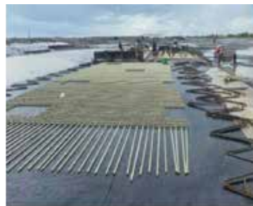
a) - GFRP cho công trình mặt đường tại cảng Lạch Huyện, Hải Phòng
